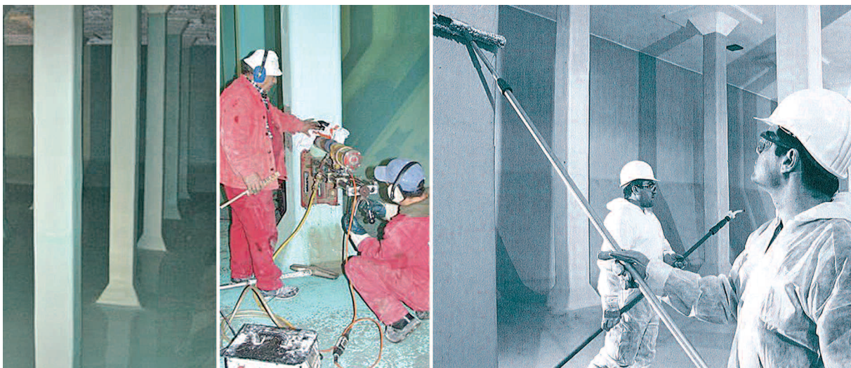
Sohle, Wände, Decken und Stützsäulen in den Wasserkammern wurden mit einer mineralischen, gesundheitsverträglichen Schutzschicht versehen.
